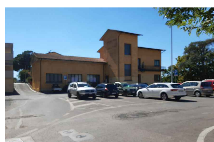
24_ex casa del Fascio
