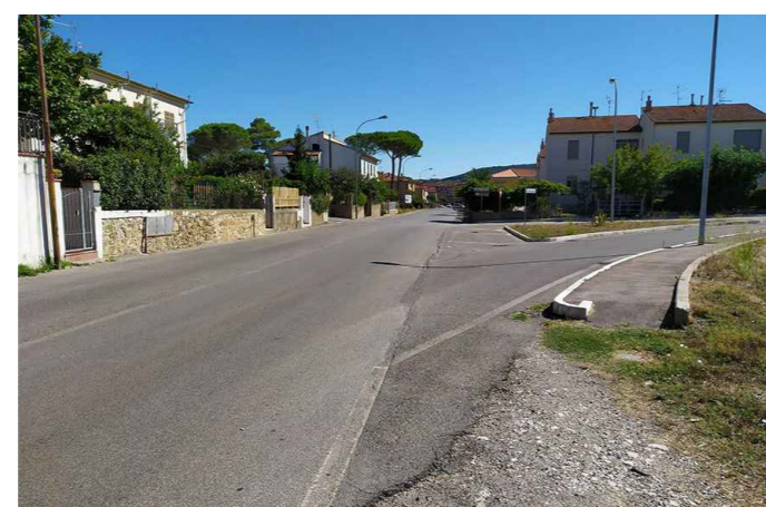
12_incrocio tra Via Rossa e Via Cavallinone
